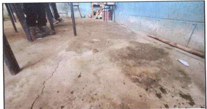
Foto 4: Se Observa que el entortado del aula 1, del modulo 3 se encuentra deteriorado y mohoso.
