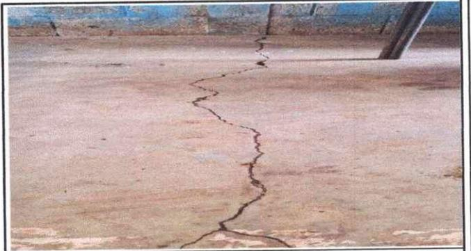
Foto 2: Se observa el piso de concreto en mal estado, por lo que sera sustituido por piso ceramico.
