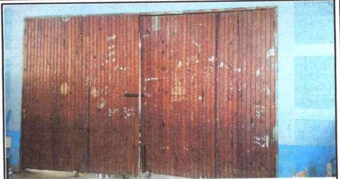
Foto 8: Se observa las divisiones de madera, por lo que seran sustituidas con block.
