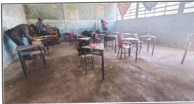
Foto 5: Se observa que el aula 2 del modulo 3, se encuentra en mal estado y esta mohoso a causa de la humedad.
