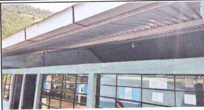
Foto 7: Se observa dos aulas del modulo 2 con baja altura de block, quedando descubiertas.
